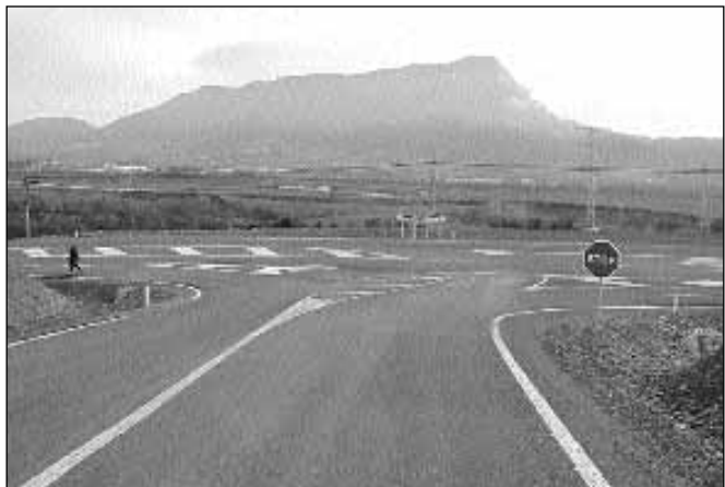
GUASILLO. Nuevo cruce en la carretera
