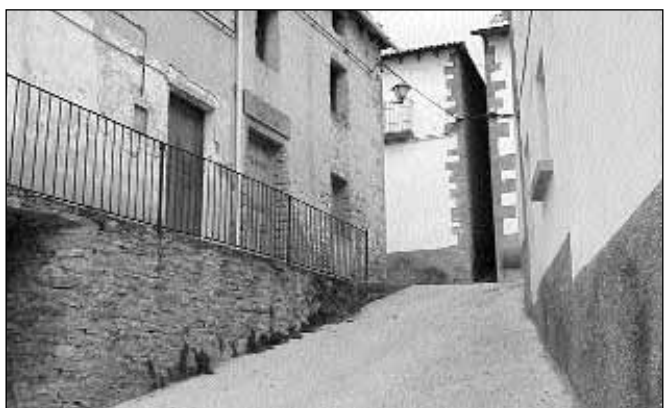
ABENA. Pavimentación de calles, nuevo alumbrado y próxima rehabilitación del centro social
