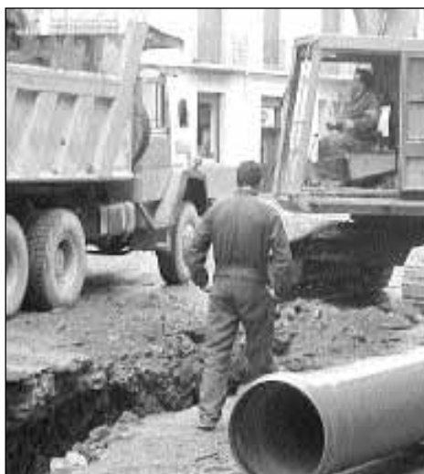
Finalizadas las obras del nuevo colector en la Avda. Jacetania
