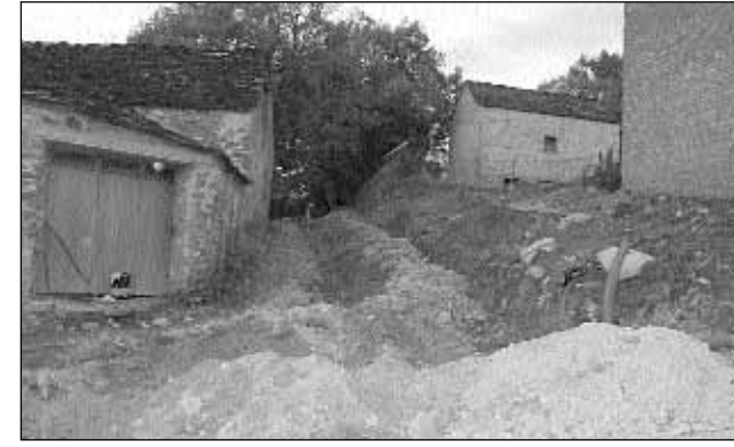
CANIAS. Pavimentación de calles, nuevos alcantarillado, alumbrado y parque infantil
