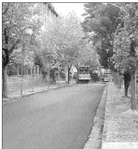
Terminan las obras del Paseo de la Constitución
