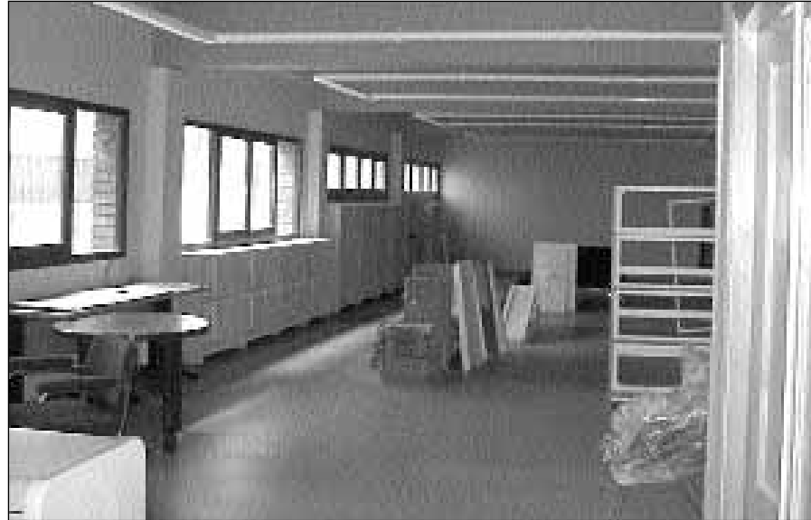
Obras de ampliación de la biblioteca municipal
