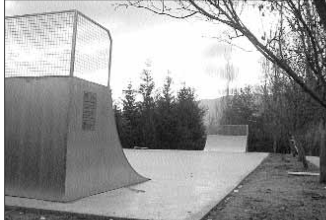
Construida la primera fase de la pista de patines
