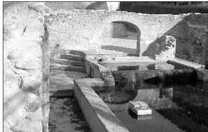
Acondicionamiento de los Lavaderos de Jaca en la Bajada de Baños
