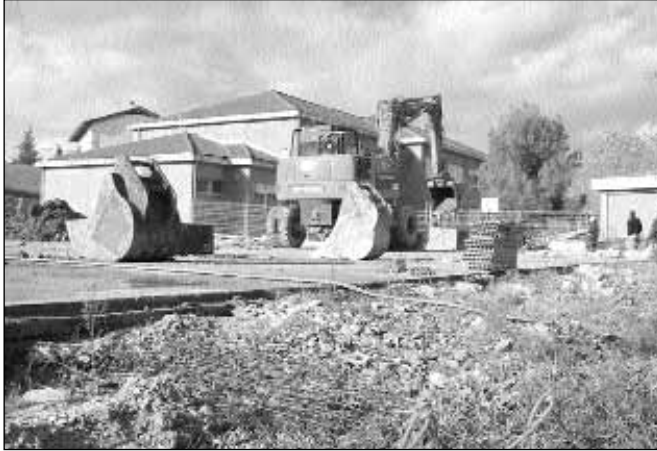
Comienzan las obras del Polideportivo del barrio norte
