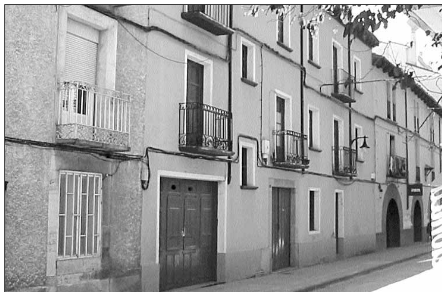
Fachada de la casa sita en la calle del Carmen adquirida por el Ayuntamiento
