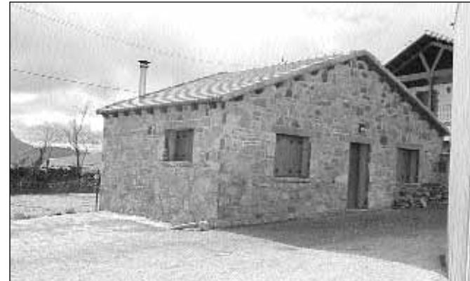
IPAS rehabilitación del centro social, pavimentación de calles, alcantarillado y alumbrado nuevos
