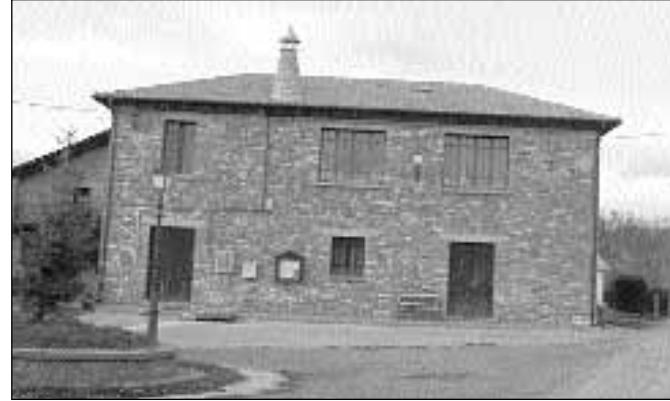
ABAY rehabilitación del centro social, nuevo muro y nueva iluminación
