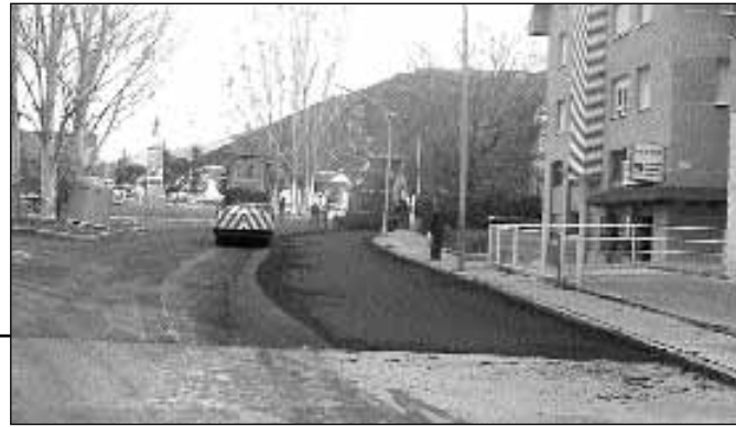
Se asfaltan 5 km de calles en el Barrio Norte
