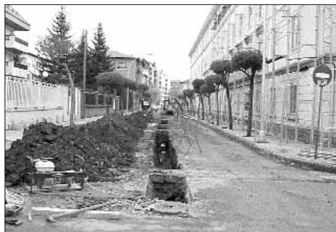
Obras para colocar el nuevo colector en la calle Universidad
