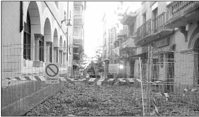
Remodelación de la calle Unión Jaquesa
