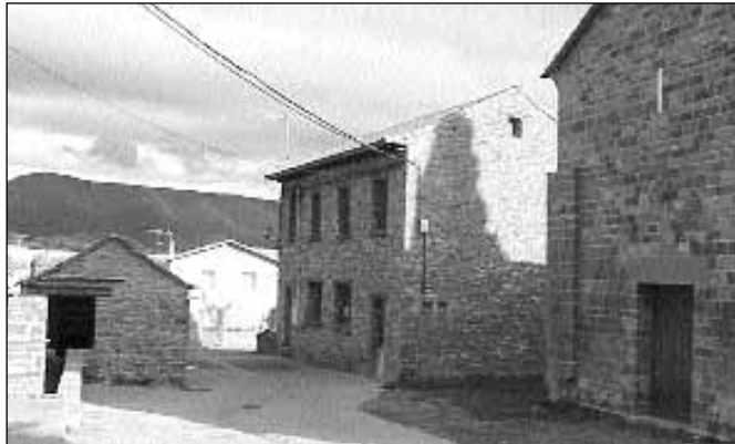
BAROS rehabilitación centro social, lavadero, pozo y nueva iluminación
